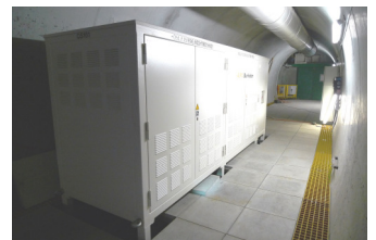
Einbau der Container in den Tunnel-Querstellen
