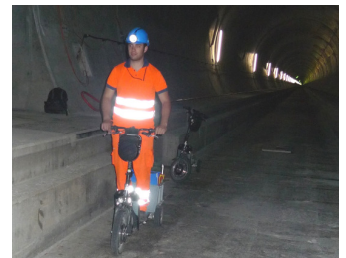
Verschiebung per Elektroroller zwischen den Querstellen
